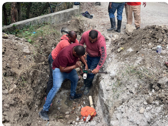
Les habitants et les techniciens s'activent pour acheminer l'eau vers les communautés voisines
