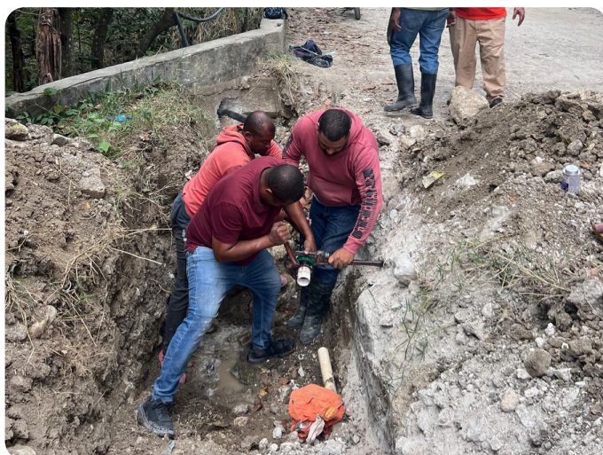
Comunitarios y técnicos realizan trabajos para llevar agua a las comunidades aledañas
